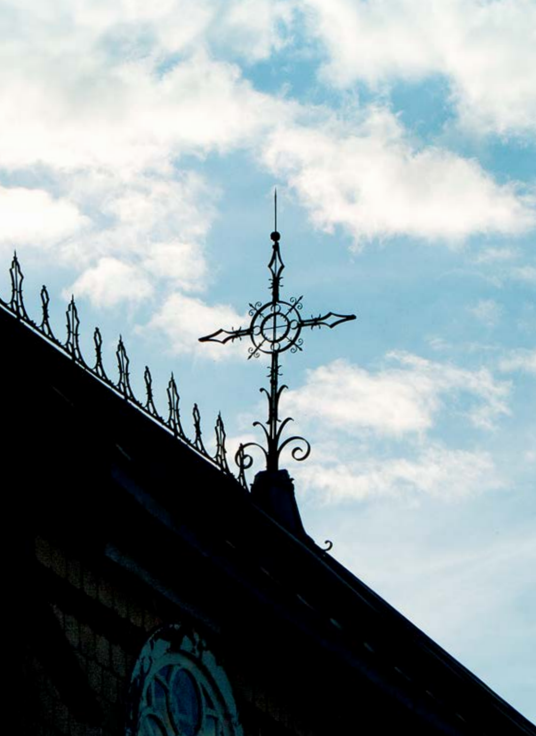
Croix du pignon en fer forgé
